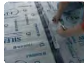
4. stabilizzazione del manto tramite nastratura delle giunzioni.
