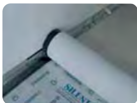
2. srotolamento dei teli
