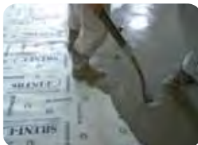
6. getto del massetto di regolarizzazione
