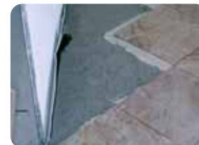
8. posa pavimento finito
